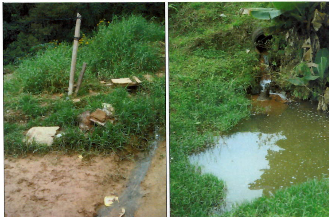
Figura 2: Canais de Esgotos 2
