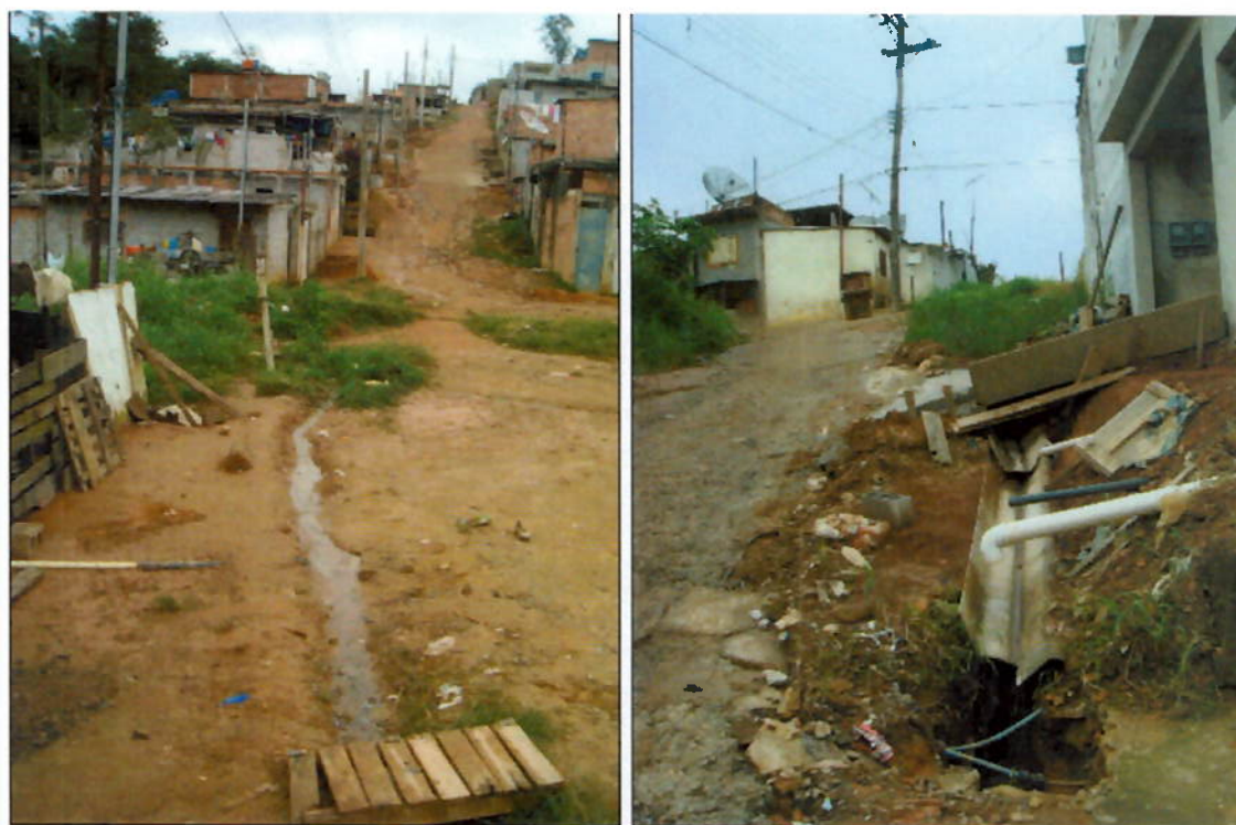
Figura 1: Canais de Esgotos 1
